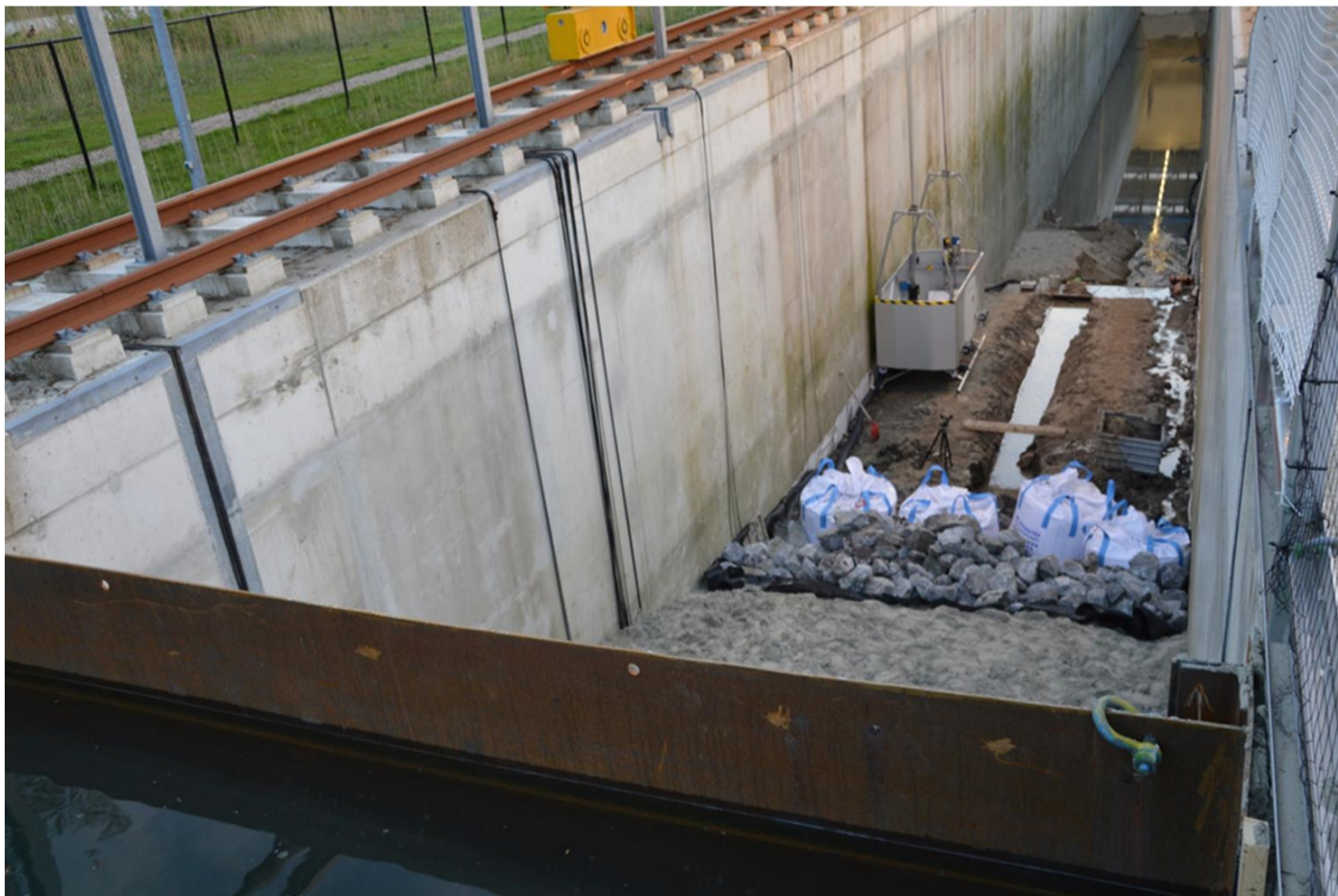
Proefsituatie met damwand in dijk t.b.v. verhoging van verval: blik vanaf buitenwater op kopsloot.
